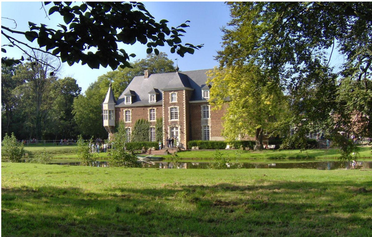
Zuidgevel van het kasteel met hoektorentje links en orangerie rechts (e.c.)
